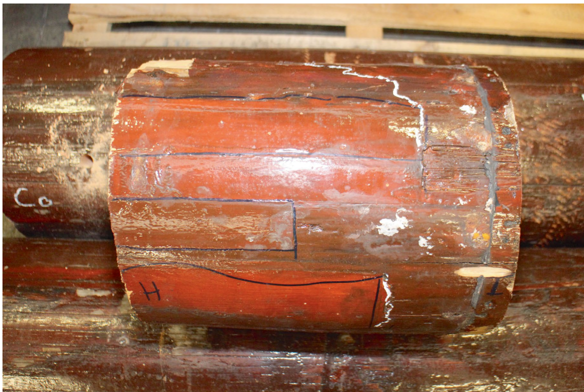
Figuur 12: Mastdeel achter de gaffelplaat met zichtbare reparaties. Bron: Onderzoeksraad voor Veiligheid
