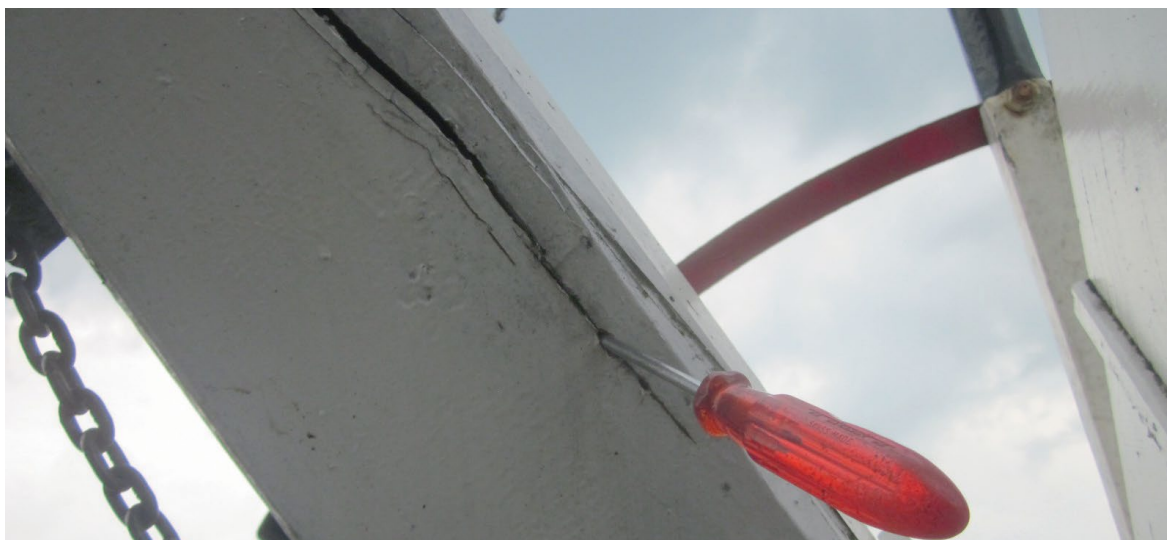
Figuur 33: Aantasting bij een windscheur. Foto: Van Reeuwijk bouwmeester
