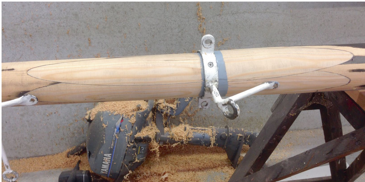
Figuur 19: Reparatie van houtrot. Bron: Jachtwerf fa. M. van Duivendijk
